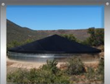
DAM MET SKADUNETSTRUKTUUR
